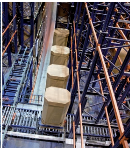
Convoyeurs pour allée de stockage.
